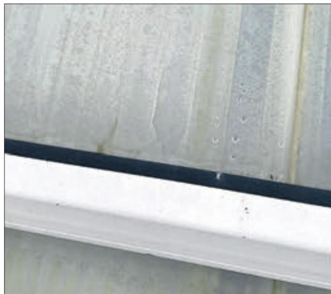
Die Lichtbänder in der Palling Turnhalle sind beschädigt und somit nicht mehr dicht. Infolge dessen sind bereits sichtbare Verfärbungen und Wasserstreifen am Dachstuhl zu erkennen sowie Wasserlachen am Turnhallenboden, die bei Regen entstehen. Es wird empfohlen, die Lichtbänder komplett zu erneuern, um wieder eine intakte Dachhaut herzustellen.
