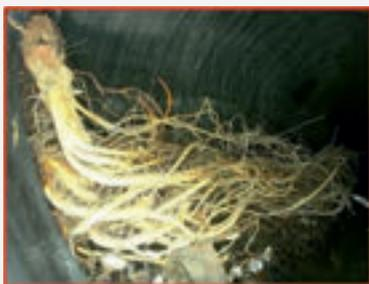
Verbreitet im Kanal: In vielen Bereichen des Regenwasserkanals sind teilweise starke Wurzeleinwüchse festzustellen. Hier drohen Undichtigkeiten und weitere Schäden im Kanal, des Weiteren wird die Reinigung und Inspektion dadurch behindert.
