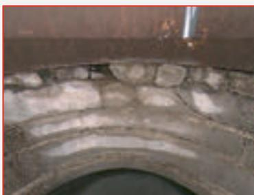
Polsing: Auch die Kanalschächte wurden überprüft. Im vorliegenden Fall drohen aufgrund mangelnder Standsicherheit der Schachtabdeckung Setzungen, welche in Folge zu weiteren Schäden an der Oberfläche und der Straße führen.
