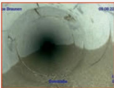
Seestraße: Im Betonrohr haben sich Risse und Scherben gebildet, die sich über den kompletten Rohrquerschnitt erstrecken. Es sind erste Verformungen erkennbar, die Standsicherheit ist beeinträchtigt, der Kanal ist undicht und Abwasser tritt aus. Auch hier sind in weiterer Folge Setzungen möglich.
