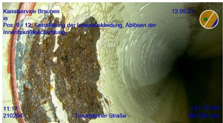
Bild unseres Kanals in der Traunsteiner Str. mit gesammelten Informationen wie Durchmesser (250mm) und Schäden wie das Ablösen der Beschichtung.
