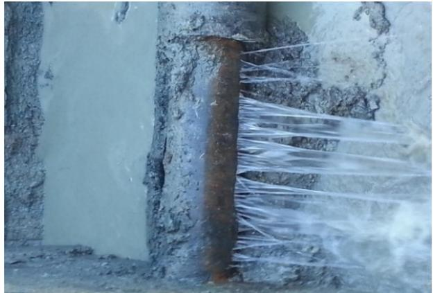
Eine Leckstelle der Hausanschlussleitung. Besonders an den nicht sichtbaren Teilen des Kanalsystems bleiben Schäden oft lange unbemerkt und ziehen größere Folgeschäden nach sich.
